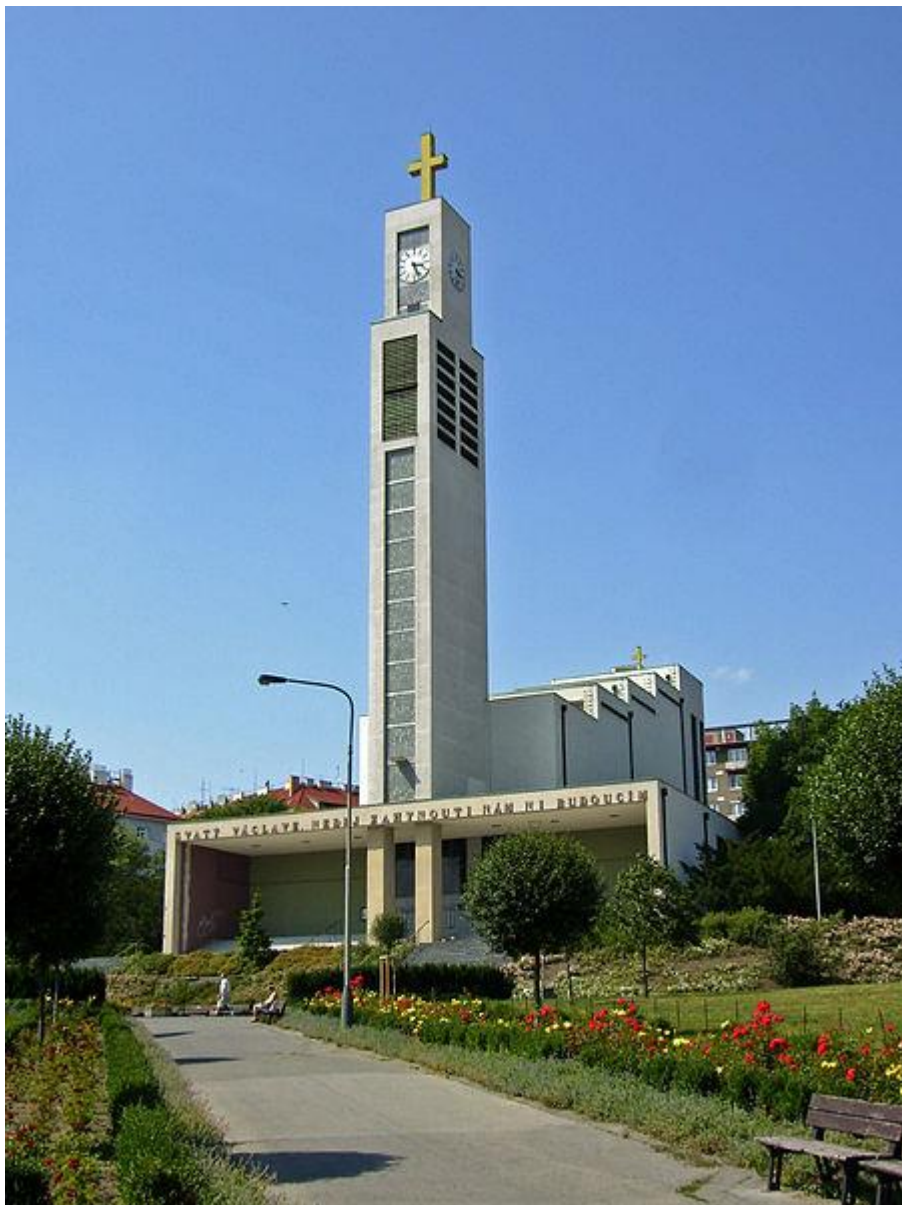
obr. č. 4 Kostel sv. Václava v Praze Vršovicích
